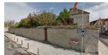
14 rue Saint-Jean. Ancien refuge de Preuilly : salle basse voûtée et restes de murs (Inv. M.H. : 17 avril 1931)
