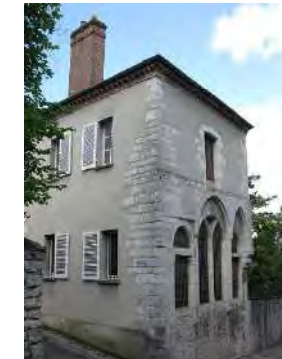
50 rue Saint Thibault. Maison dite de « Saint- Thibault » ou « des Orphelines » façade sur rue, cave voûtée (Inv. M.H. : 17 avril 1931)
