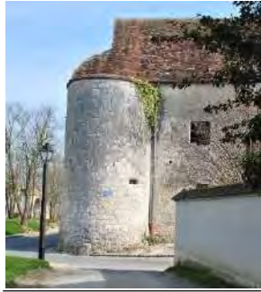
Rue de Jouy. Ferme de la Madeleine: tourelle d'angle et les deux salles voûtées (Inv. M.H. : 11 mai 1932)
