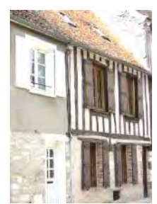
6 rue Saint-Jean : façade sur rue et toitures; cave voûtée (Inv. M.H. : 11 décembre 1935 et 15 janvier 1962)
