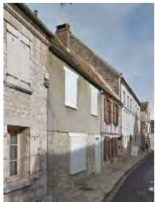
6 rue Saint- Thibault: façade sur rue et toitures; cave voûtée (Inv. M.H. : 11 décembre 1935 et 15 janvier 1962)
