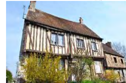
54-56-58 rue Saint Thibault : façades et toitures (Inv. M.H. : 16 juillet 1970)
