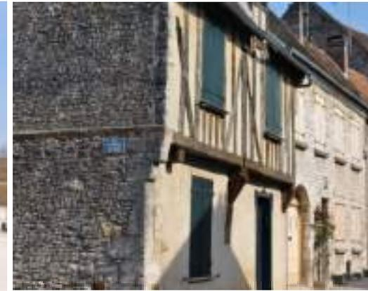
*La plupart des constructions reposent sur un mur bahut de quelques dizaines de centimètres.*
